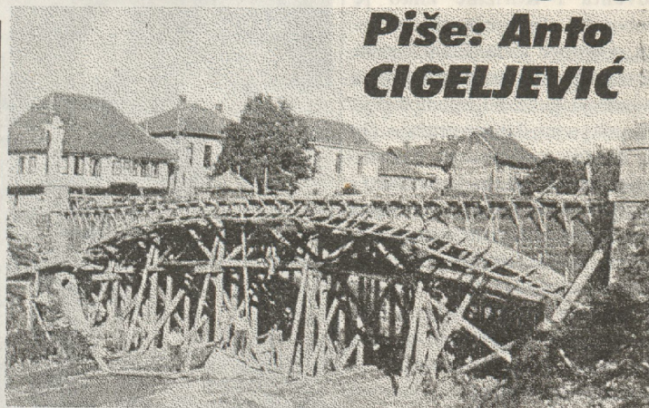
Gradnja betonskog mosta sa Lederovim kipovima na Jali 1935.
