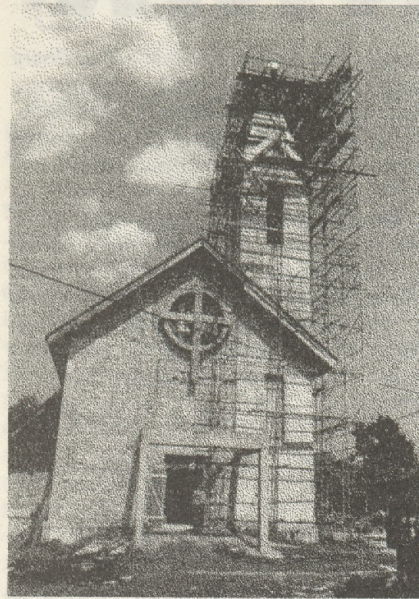
Crkva u izgradnji
