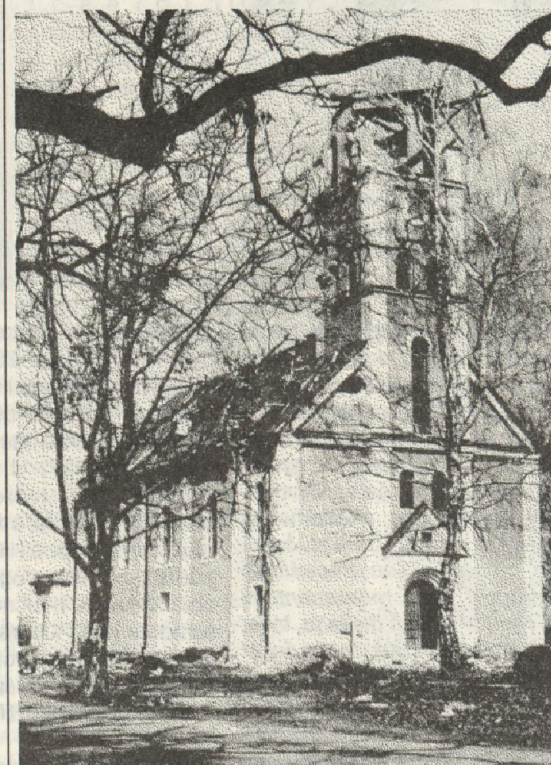
Oštećena župna crkva u Dubravama
